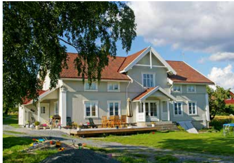
Hovedbygningen i Bortigarden Bjørke består av to eldre tømmerhus fra 1700-tallet som er satt inntil hverandre. I 1922 ble det påbygd én etasje. Bygningen framstår i dag med mange av sveitserstilens detaljer. Foto: Jørn Jensen
