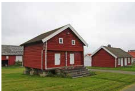
Stabburet på Bjørnstad er fra 1800-tallet, og flere av laftestokkene trengte å skiftes ut. Med midler fra Steinssletta kulturlandskap er stabburet nå satt i stand. Bildet til venstre er fra før restaureringen. I bakgrunnen bryggerhuset/drengestua fra før 1780 (restaurert 1995). Den solide stabburstrappa i stein på Bjørnstad er også blitt restaurert (midten). Stabburet på Bjørnstad etter restaureringen i 2012-13 (til høyre). Foto: Knut Opdal
