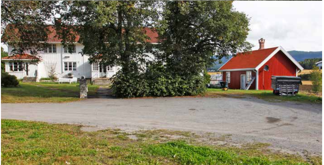
Fra tunet i Høgstua Hurum i 1905 (øverst) og 2014. På det eldste bildet seg vi forpakter Syver A. Hurum på slåmaskinen, og i bakgrunnen til høyre står Ola Kornbråten. Merk dueslaget foran hovedbygningen. Hovedbygningen er fra 1700-tallet (den eldste delen sannsynligvis enda eldre), og ble restaurert i 1927 og 1988. Foto: Oskar Puschmann, Skog og landskap
